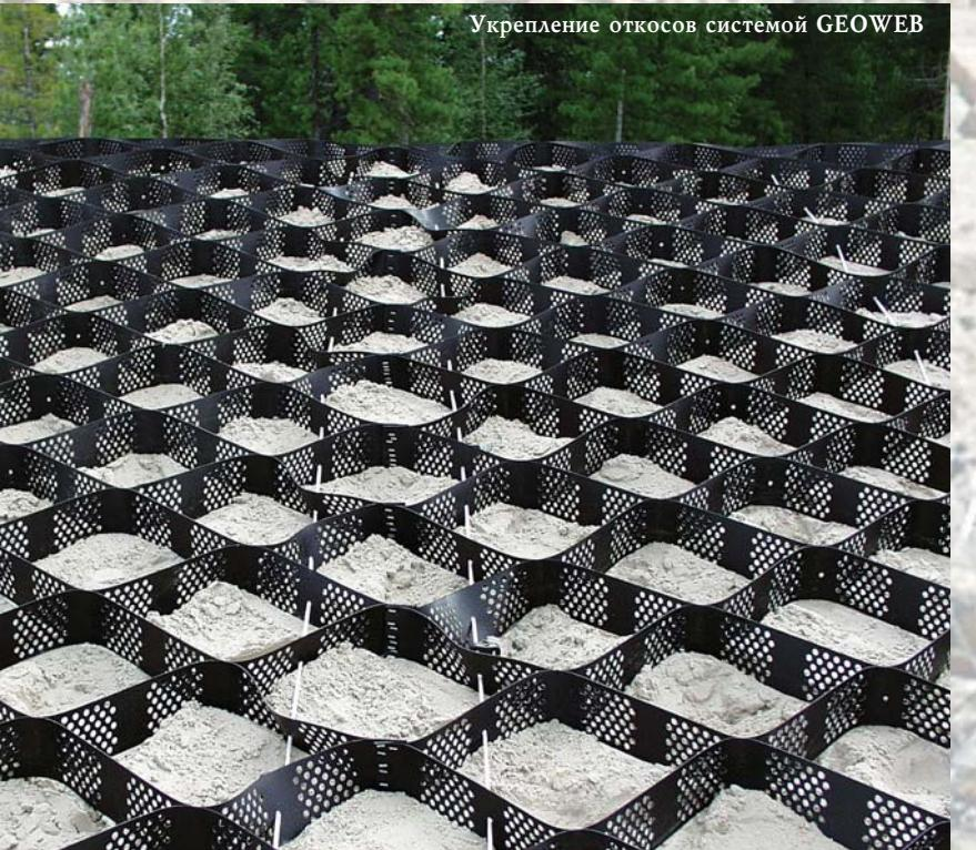
Укрепление откосов системой GEOWEB
