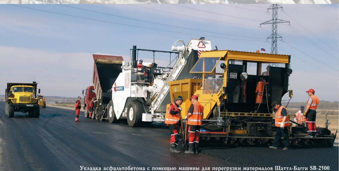
Укладка асфальтобетона с помощью машины для перегрузки материалов Шатт-Багги SB-2500
